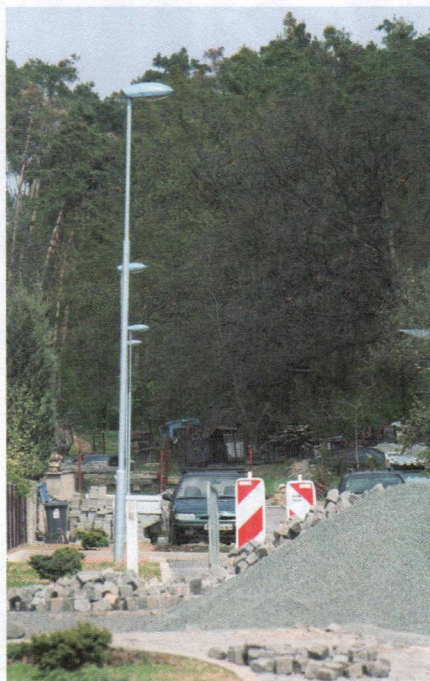
Snímek zachycující rekonstrukci
