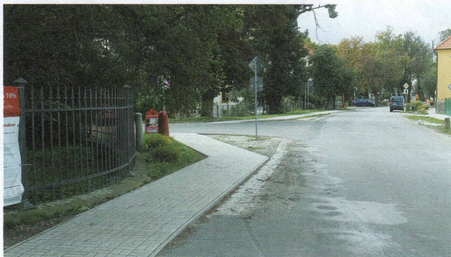
Nový chodník vznikl i na místě, kde byla předtím vozovka
