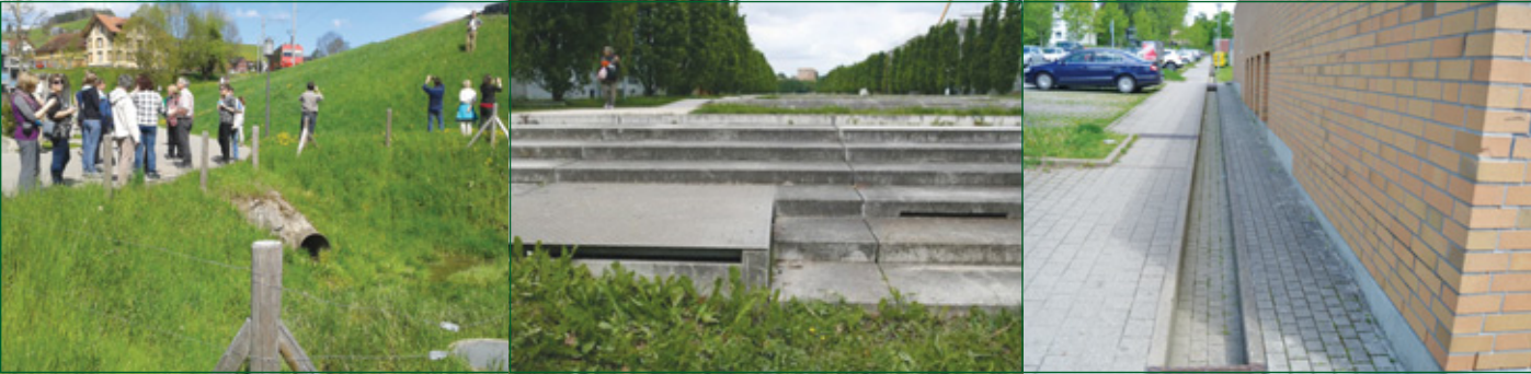
Retenční nádrž/vsakovací průleh Appenzell
