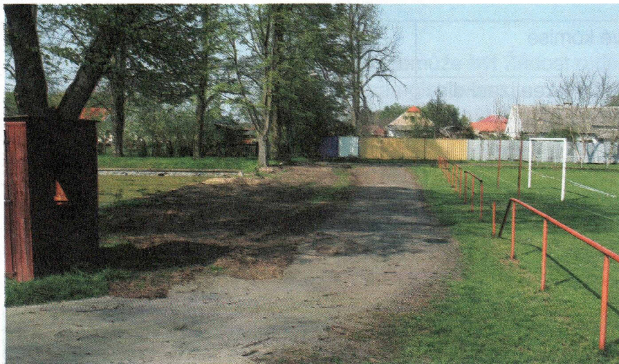
Nádrž s hřištěm před rekonstrukcí
