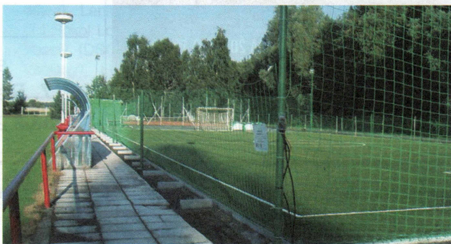
Hřiště po rekonstrukci
