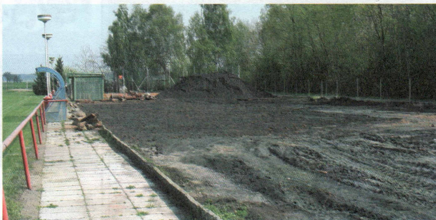
Hřiště před rekonstrukcí
