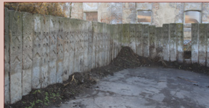
Hnojiště před rekonstrukcí
