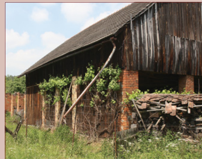
Stodola před rekonstrukcí
