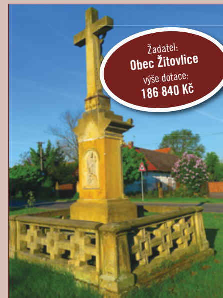
Kamenný kříž před rekonstrukcí
