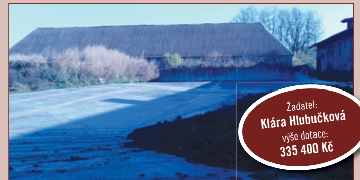
Hnojiště po rekonstrukci
