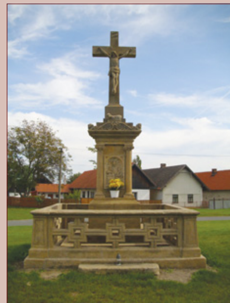
Kamenný kříž po rekonstrukci
