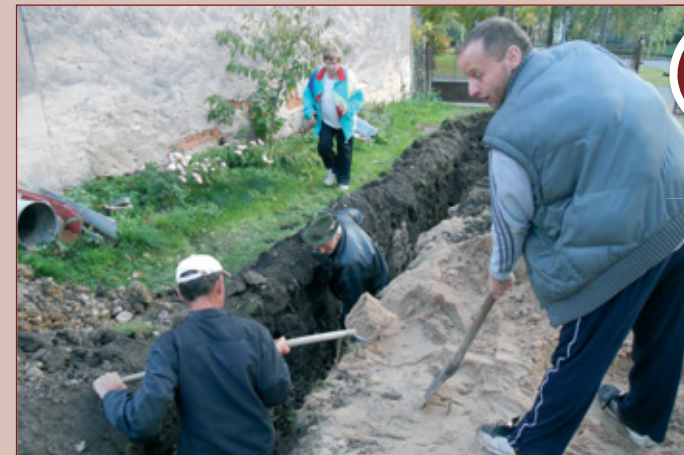
Mcelští občané při práci na kanalizační přípojkě u zbrojnice
