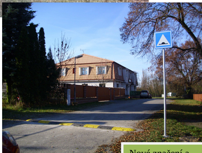
Nové značení a zpomalovací práh
